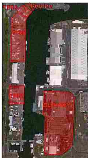
Figure 5 : Les terre-pleins actuels dédiés à la réparation navale sont tous situés au Port Ouest
