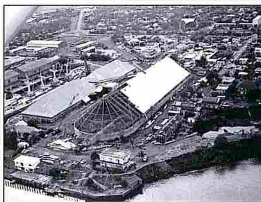
1969, vue aérienne terminal sucrier Travaux de construction de la cellule 72 du silo à sucre
