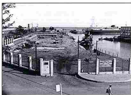
1963, Bassin Emile HUGO Démarriage des travaux des cellules 70 et 71 du silo à sucre
