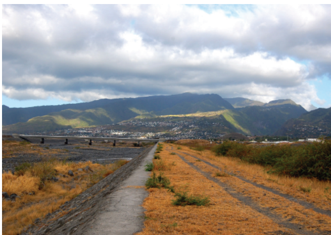
Digues de la rivière des Galets, Saint-Paul
